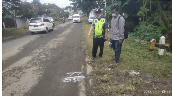
Survey Kondisi Jalan Eksisting (Sumber : Dokumentasi pribadi tgl. 19-01-2022 )
