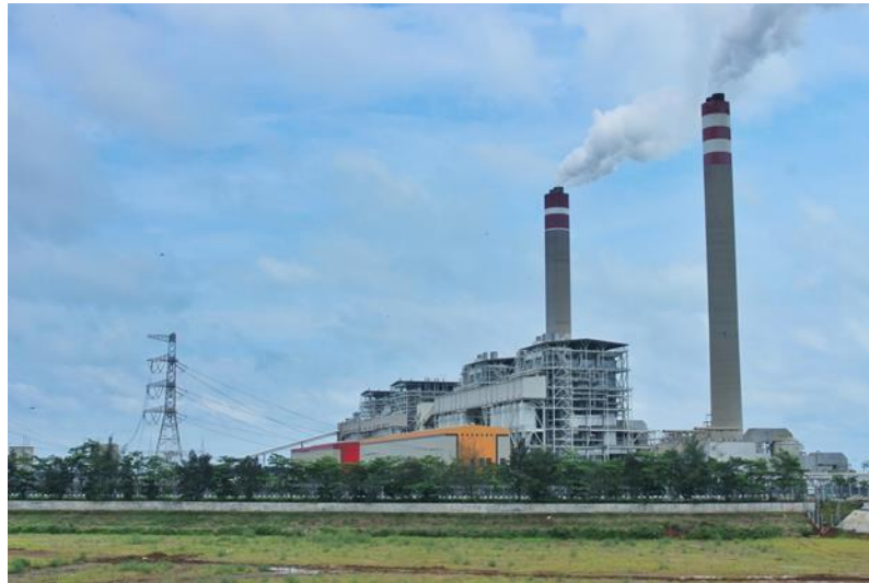
PLTU Tanjung Jati B Jepara (sumber : google )
