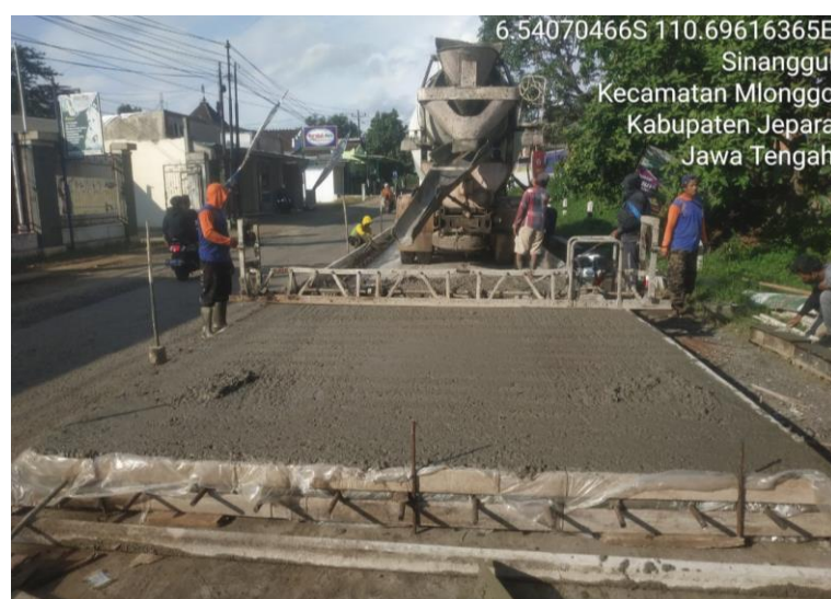
Pengecoran Fs-45
