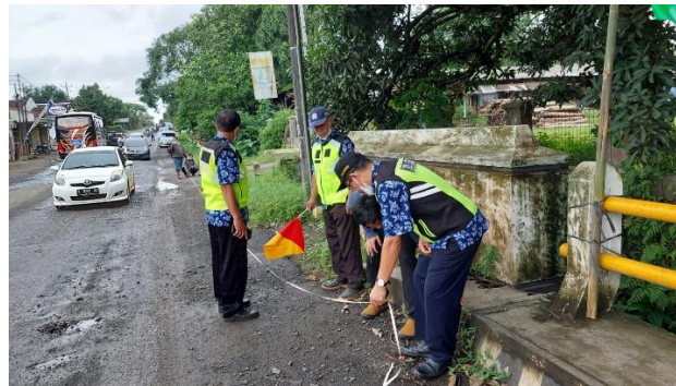
Survey kondisi jalan eksisting (Sumber : Dokumentasi pribadi tgl. 19-01-2022)
